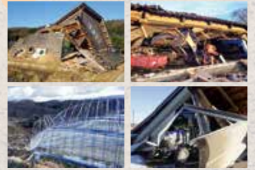
■個人所有施設[納屋倒壊、亀裂、地盤沈下等]
